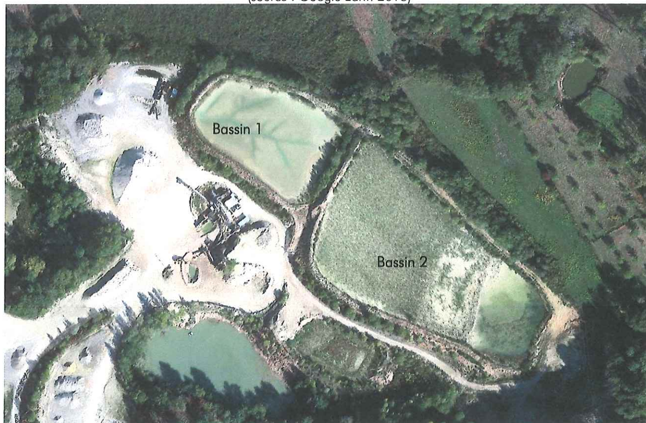
Photo aérienne des bassins (source : Google Earth 2016)
