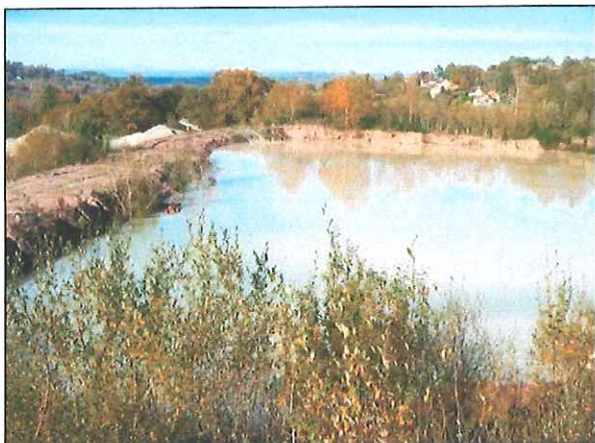
Bassin de décantation en cours de remplissage
